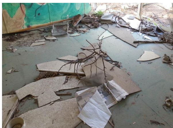
מבנה המועצה הישן (סולם צור) שברי ולוחות אסבסט לפינוי
